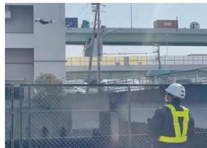
ドローンによる水道橋点検の様子
