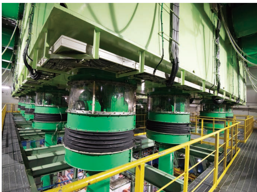
震動台の地下部分。鉛直加振機が14台並んでいます
