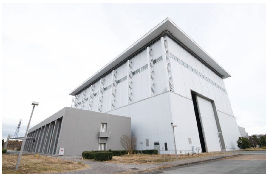
実験棟は震動台があるE-ディフェンスの主要部分。建物の高さは約43mで、床面積は約5,200㎡
