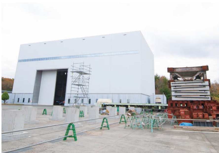
実験準備棟では実験のための試験体を製作。150tクレーンが設置されています
