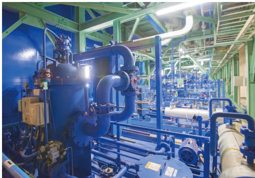
震動台の動力となる油圧ポンプ
