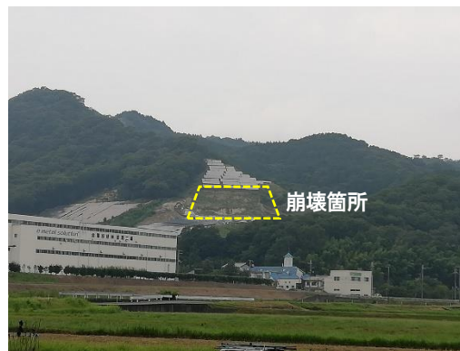
図 4 姫路市の太陽光発電所における斜面崩壊
