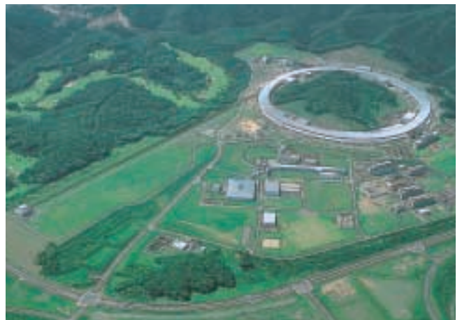
大型放射光施設SPring-8全景 (撮影/2001年8月)
