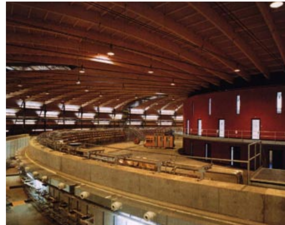
建設中のSLS (Swiss Light Source) 放射光施設 木造の天井が美しい (スイス ビリゲン)
